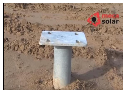
Fotografía 9 Pilar donde será atornillado los soportes del panel solar.
