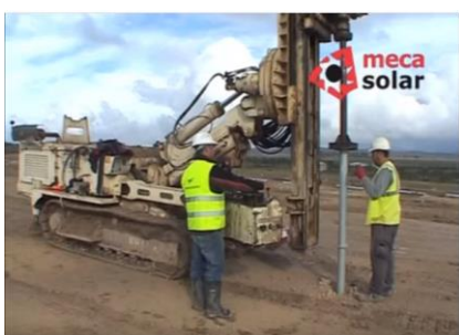
Fotografía 7 Hincado de pilares directo a la roca en área perforada.
