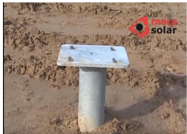
Figura 5 Estructura ya hincada a 1.20 m.
