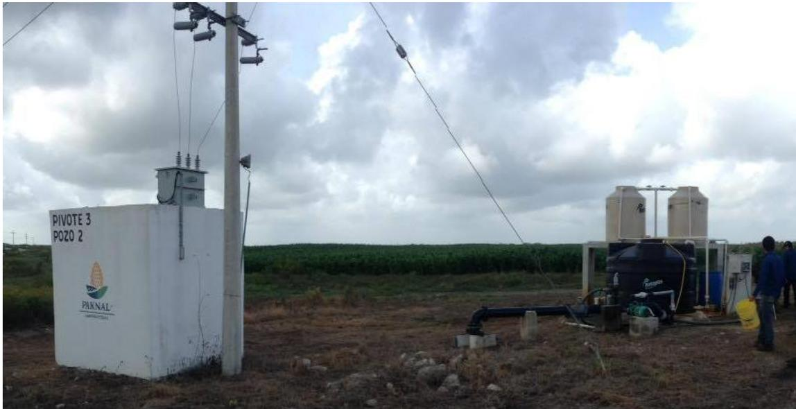
**Figura 2. 12.** Vista de un pozo con fuente de suministro eléctrico y equipo de inyección de fertilizante (Nota: Hay que tener en cuenta que esta figura es ilustrativa, no corresponde al sitio del cual corresponde el proyecto).
