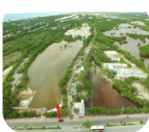
Figura II.7. Vialidad de acceso durante la construcción del proyecto
