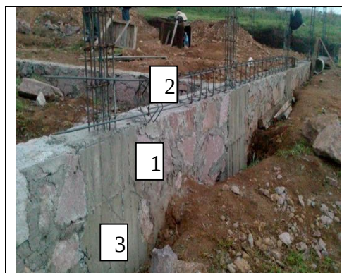
Figura II.11. Ejemplo de trabajos de cimentación
