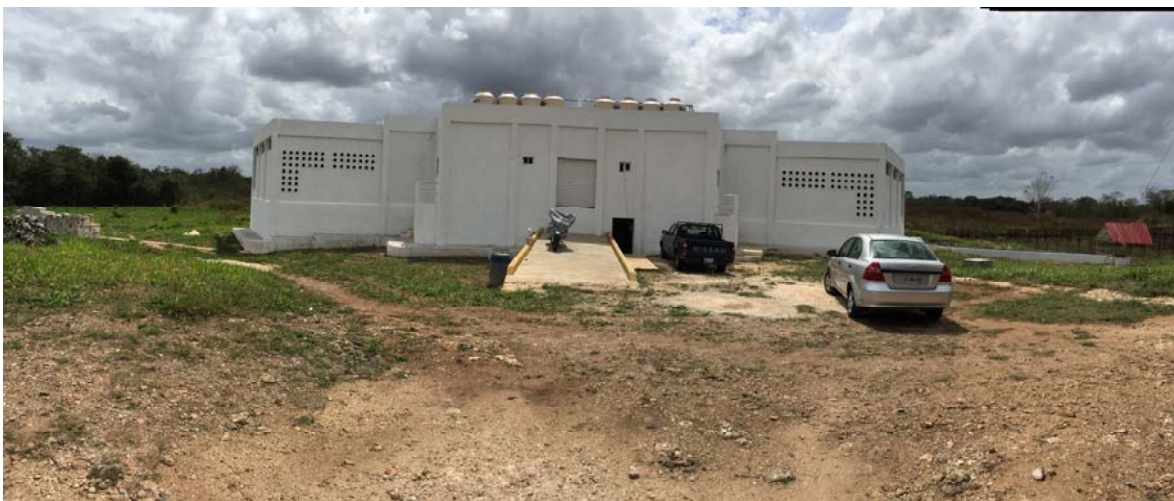
Figura 16. Infraestructura existente utilizada anteriormente para actividades pecuarias y en proceso de rehabilitación y modificación
