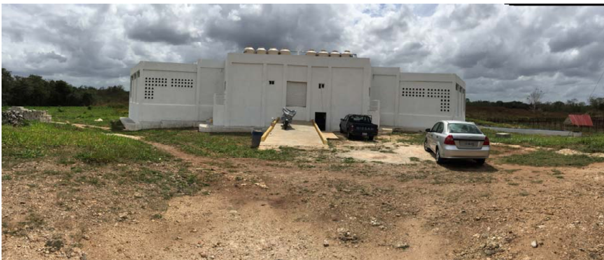
Foto 6. Infraestructura existente construida hace más de veinte años, que se modificará y rehabilitará
