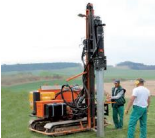
Perforación para hincar soportes
