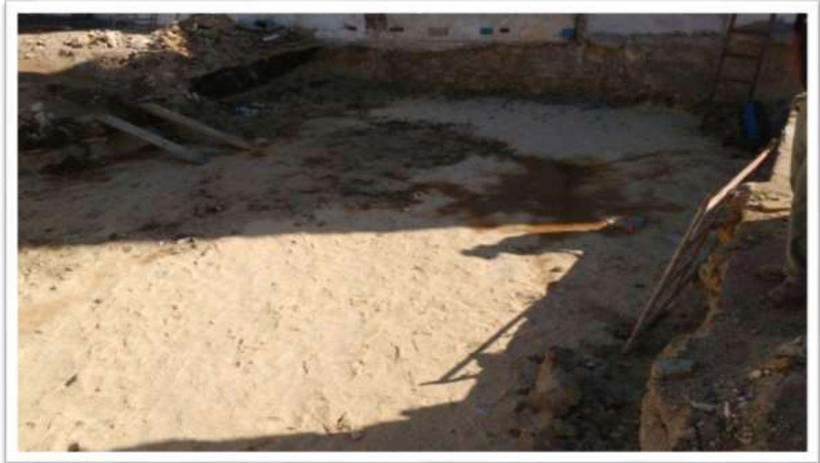
**Fotografía 11.** Vista de la excavación realizada, debido a la demolición del sótano de una de las viviendas que ocupaban el sitio del proyecto
