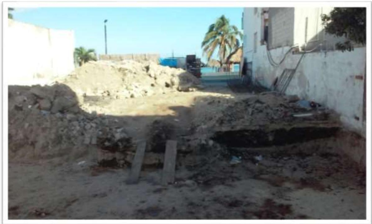
**Fotografía 12.** Vista de la excavación realizada, debido a la demolición del sótano de una de las viviendas que ocupaban el sitio del proyecto
