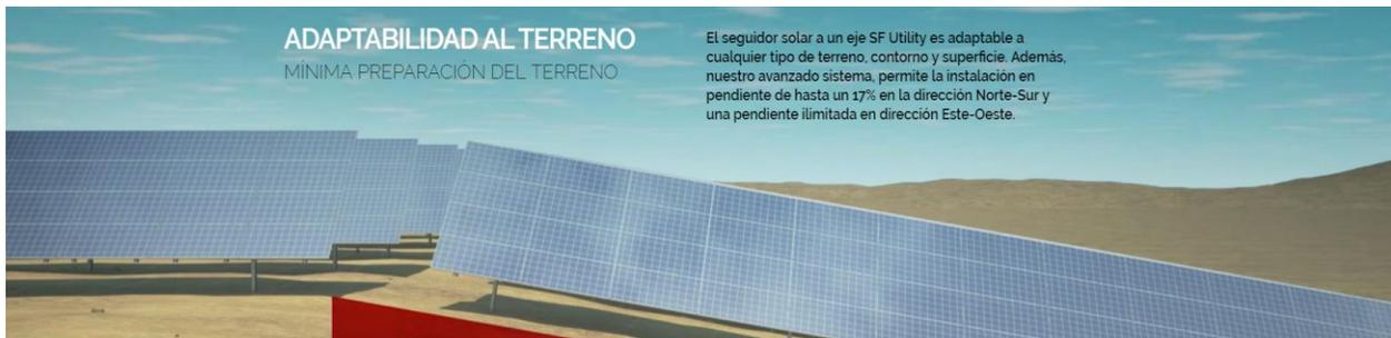
Frente a fuertes vientos los seguidores soportan hasta 80 Km/h en función de seguimiento, cuando detecta vientos superiores a dichos 80 Km/h pasa automáticamente a posición de seguridad horizontal (**Stow Position**) soportando vientos de **mas de 200 km/h.**
