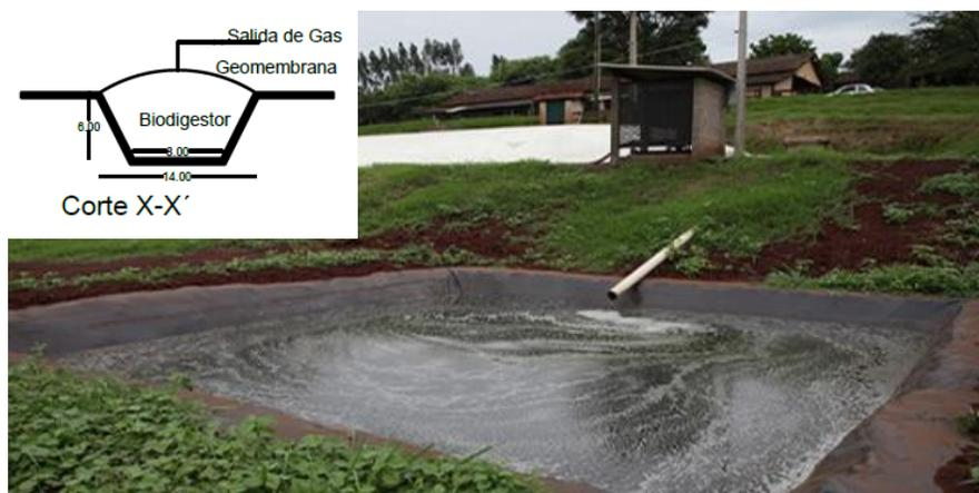
**Figura 2. 23.** Laguna de sólidos que compone el biodigestor.
