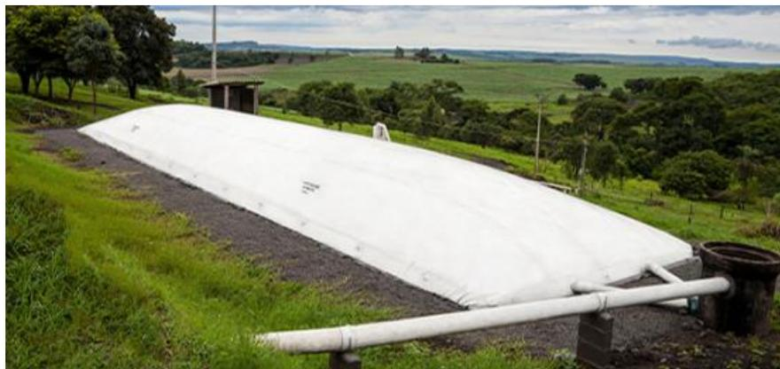
**Figura 2. 24.** Componentes del Biodigestor de geomembrana.
