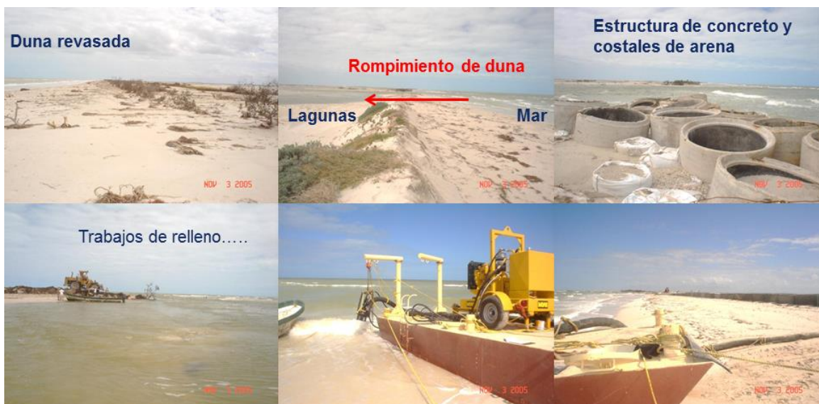
Figura 2: Obras emergentes para daños ocasionados por el paso del Huracán Wilma.
