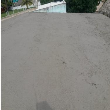
Colocadas las bovedillas sobre las viguetas se procede a colocar malla electrosoldada para ir colocando sobre de esta concreto. Fraguado el concreto se procede a impermeabilizar el techo con cal, cemento y agua, mezcla que se denomina como calcreto.
