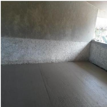
Colados los pisos se procede a revocar los techos con mortero y posteriormente las paredes. Se darán los acabados correspondientes al revoco según planos del proyecto.
