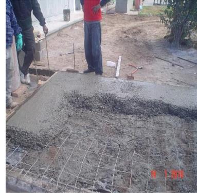
Rellenadas las cimentaciones con escombro se procederá a nivelar y compactar el relleno para colocar malla electrosoldada y depositar concreto. Es de mencionar que para el caso de los baños de la escuela, antes de realizar los colados se dispondrán las tuberías de cpvc sobre la malla electrosoldada para conformar el sistema hidrosanitario y de esta forma evitar picar el piso una vez fraguado el concreto.
