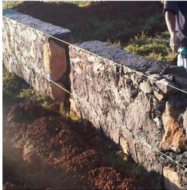
Luego con piedra caliza dispuesta de forma hilada y unida con mortero se conformarán la cimentación de mampostería.
