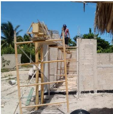
Acto seguido comenzarán las labores de bloqueadura de muros. Para esto se emplearán bloques vibroprensados, unidos con mortero (cemento portland y cal). Se empleará herramienta manual para recortar bloques en caso de ser necesario.
