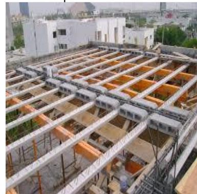
Después conformar los cerramientos e procede a colocar viguetas y disponer bovedillas entre cada una de estas para ir conformado la estructura que será el techo de las aulas de la escuela.
