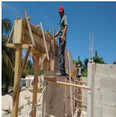
Una vez desplantados los muros se procede colocar los cerramientos, los cuales consisten en colocar armex de forma horizontal y colarlos con concreto empleando cimbras.
