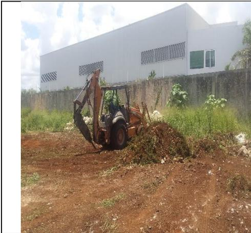
**Imagen IV.6. Operación de la retroexcavadora para remover arena dentro del predio**
