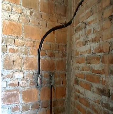
Para la instalación de poliductos y tomas eléctricas será necesario picar las paredes para crear canaletas. Estas posteriormente serán cubiertas por las tareas de revoco.
