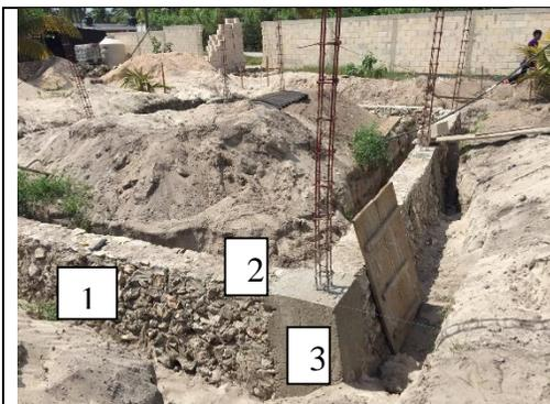
**Figura II.8. Ejemplo de trabajos de cimentación**
