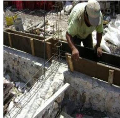
Posteriormente con ayuda de armex dispuestos tanto de forma horizontal como vertical se colarán las cadenas y dados de cimentación, empleando cimbras de madera para contener el concreto y darle una estructura uniforme. Así mismo, se procederá al relleno de las cimentaciones empleando escombro preferentemente.
