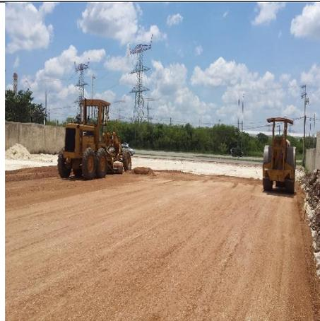
**Imagen IV.7. Trabajos de nivelación y compactación a realizar con una motoconformadora y aplanadora.**
