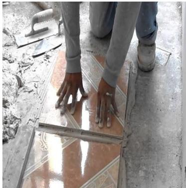
Para ir finalizando los trabajos se procede a colocar los pisos de losa sobre el piso de concreto. Cada mosaico será unido con pegazulejo.
