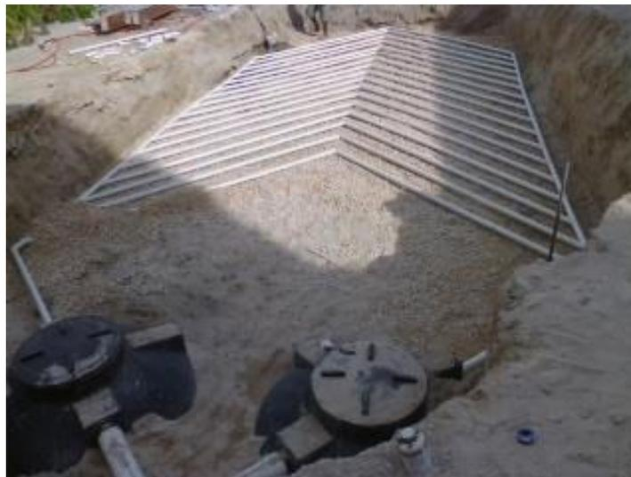
Figura II.6. Ejemplificación de un diseño de las zanjas de infiltración utilizada en la costa norte de Yucatán.
