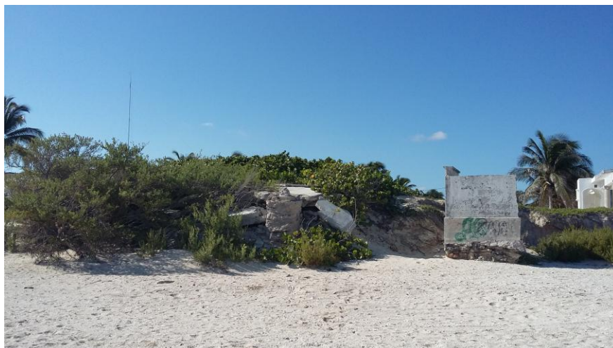
Fotografía 4.11. Escombros que quedaron en la zona norte del predio.
