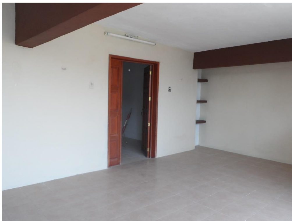
Fotografía 5. Entrada a la construcción del predio.
