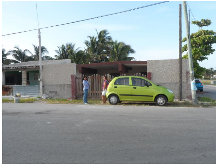
Figura 2. 5. Vista frontal del predio, en calle 19 colindante a vivienda unifamiliar y esquina con carretera pavimentada.
