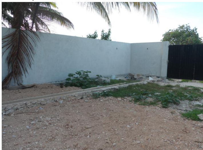
Figura 2. 3. Barda perimetral del predio.
