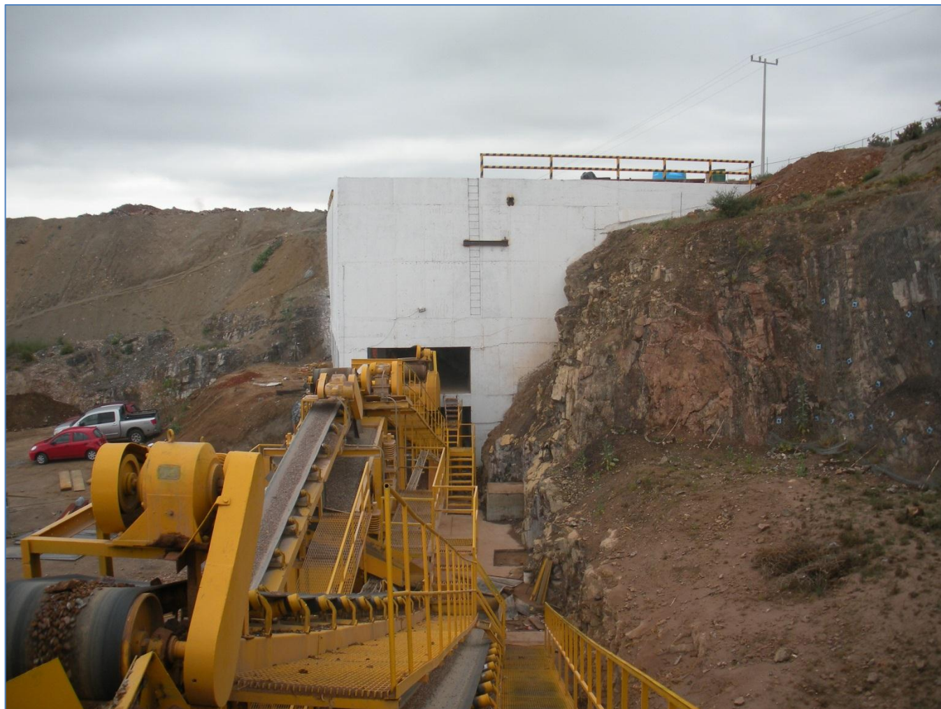
Vista del área de trituración.
