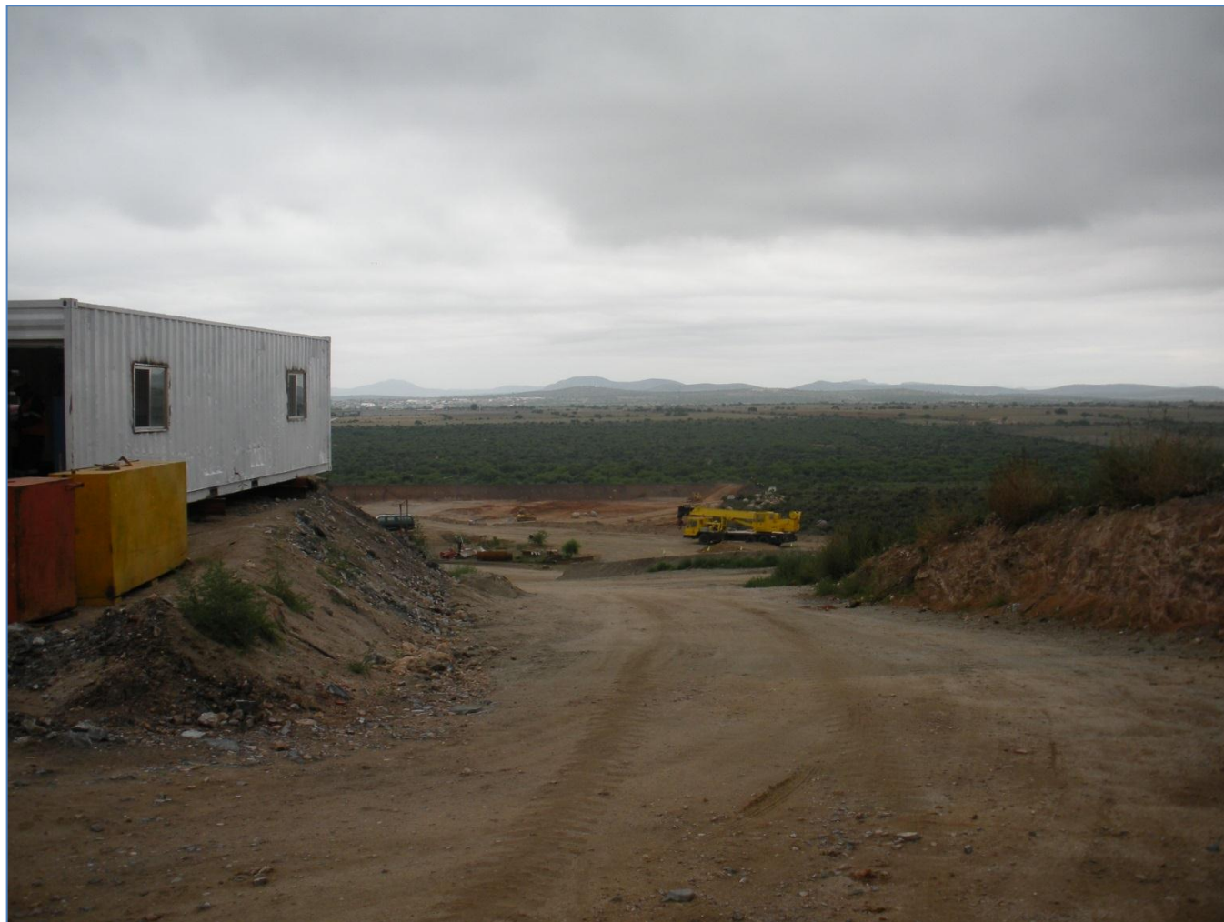
Vista al Sur de la Presa de jales en funcionamiento y desde las instalaciones de la Planta de beneficio.
