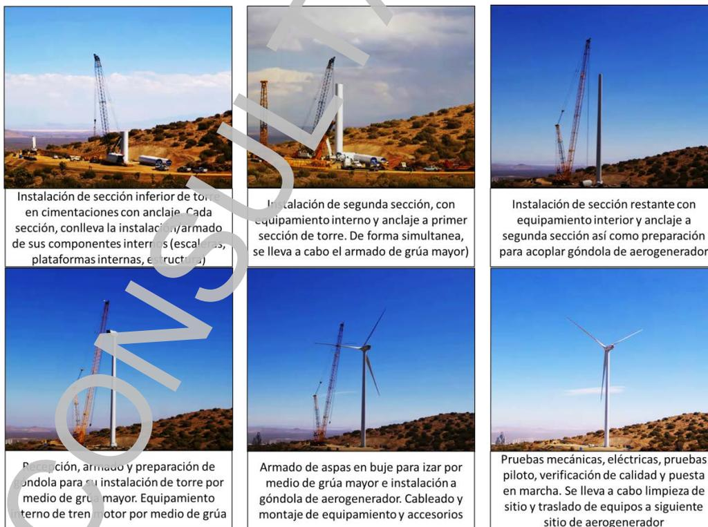
Figura 2. 11. Proceso general de instalación de aerogenerador (torre hasta puesta en marcha)
