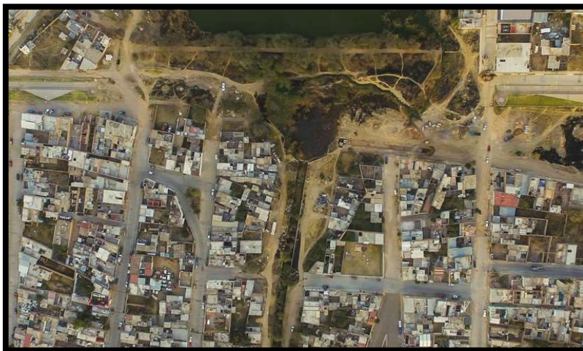
Figura II.16 Vistas áreas de la condición actual de la zona del proyecto
