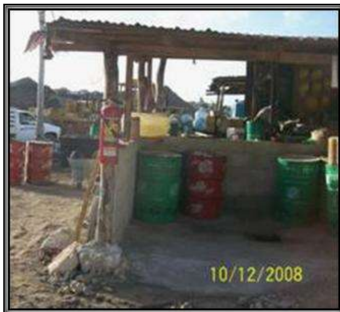
Figura VI.4 Ejemplo de un almacén de materiales en un campamento de obra
