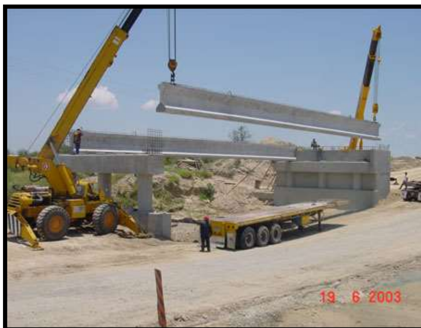
Figura V.3 Ejemplo de la construcción de un paso superior vehicular
