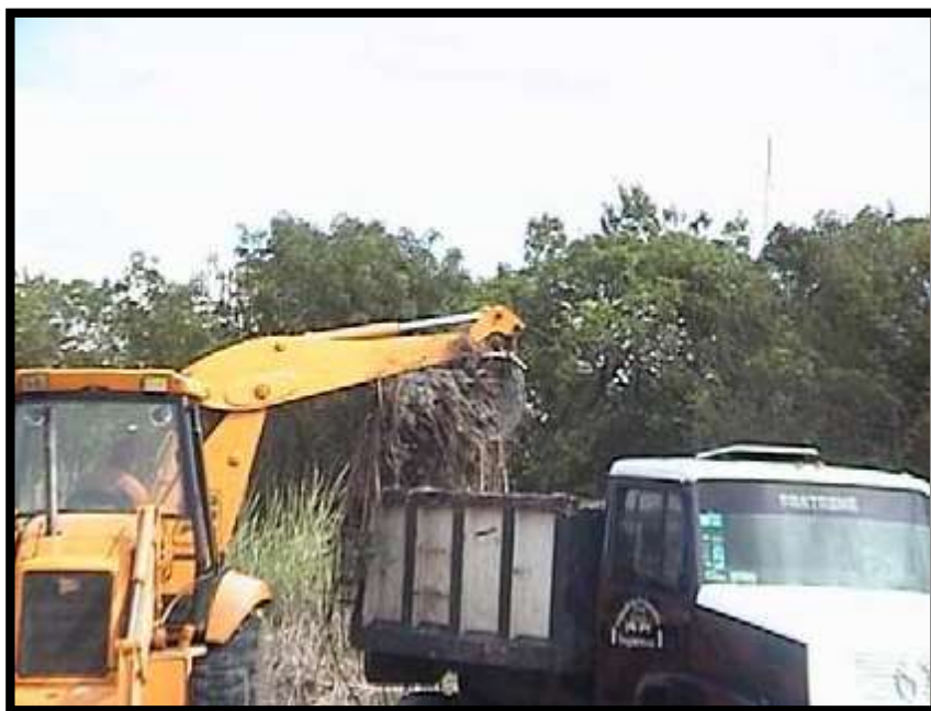
Figura VI.7 Ejemplo del manejo de residuos del desmonte
