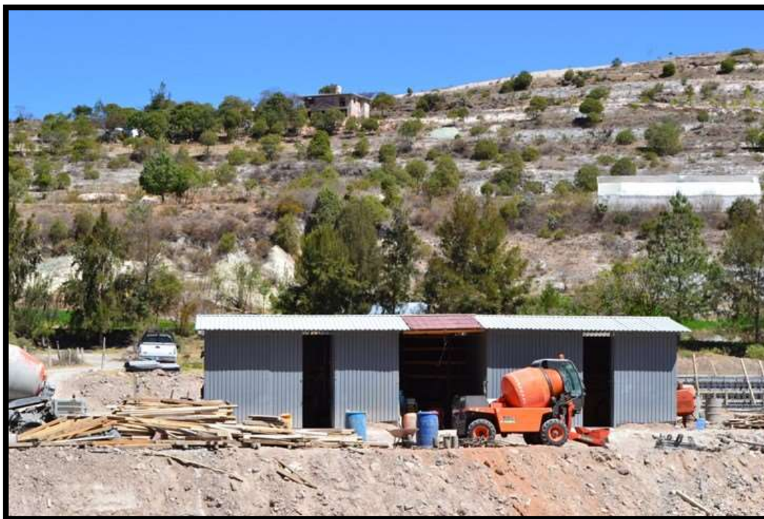
Figura II.31 Imagen de un almacén temporal como el que se requiere para la construcción del puente
