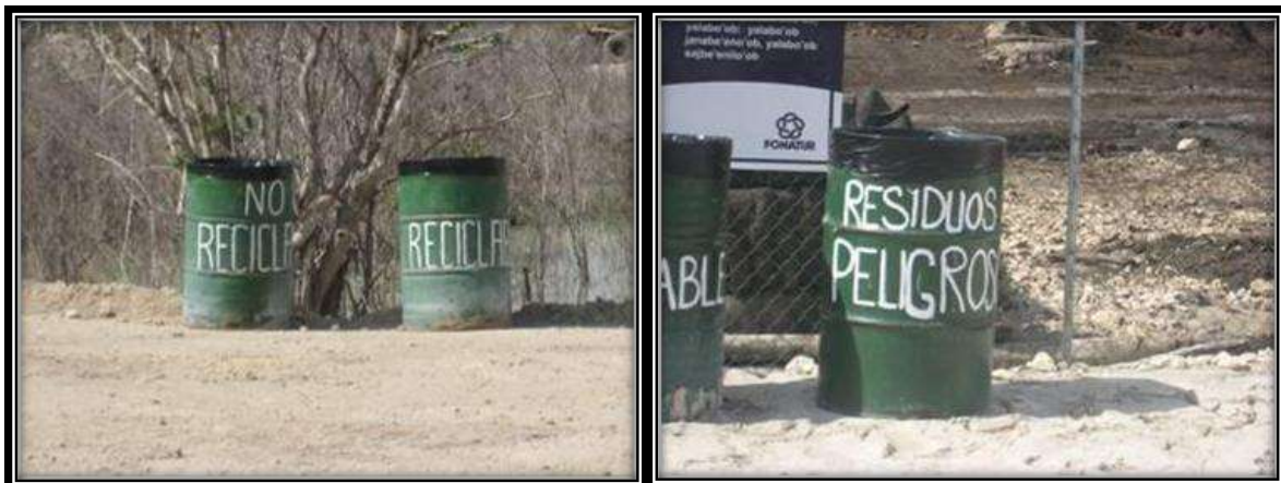
Figura VI.5 Ejemplo de la colocación de contenedores para los residuos resultantes de la construcción de la obra
