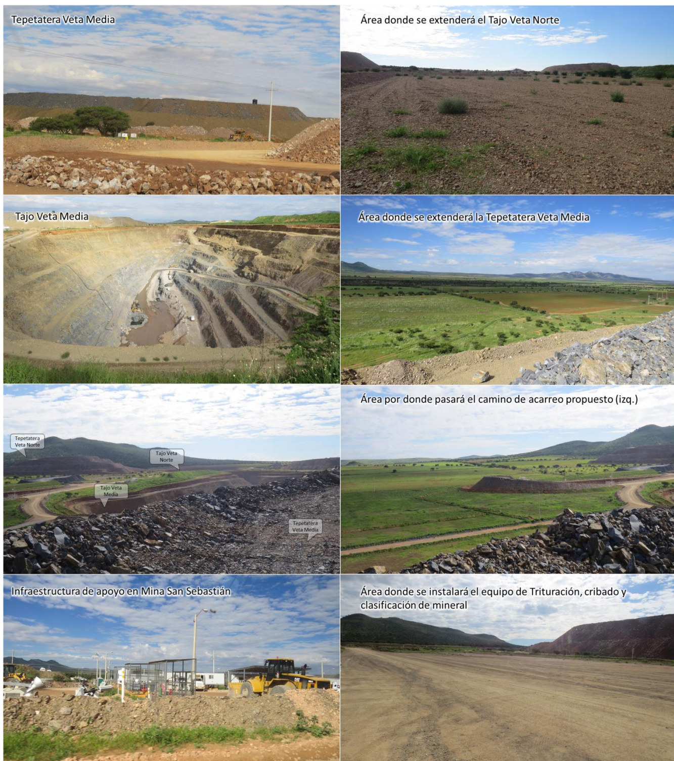
Figura 2.10. Izquierda: Obras e infraestructura existente dentro del predio de la Mina San Sebastián. Derecha: áreas que se ocuparán para las cuatro obras que se pretenden desarrollar como parte del Proyecto MII-PVM
