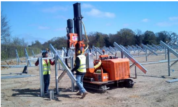
Fig. 13. Hincado de estructuras
