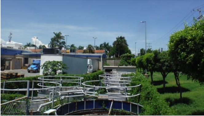
Vista de la PTAR, de Sur a Norte, donde se observan los tanques que conforman el tren de tratamiento, al fondo el cuarto de control donde se encuentra los filtros, el compresor de aire, el medidor de flujo como se puede ver se encuentra fuera de operación
