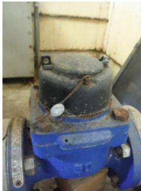
Vista del medidor de Flujo, No. 1205080076, contando con sello para evitar manipulación de las mediciones.
