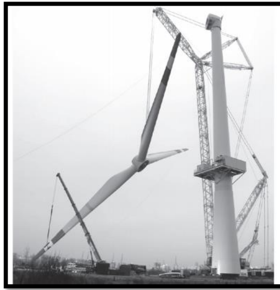
Figura II.10. Montaje del rotor utilizando una grúa principal y una auxiliar de menor tamaño. FUENTE: GASCH, Robert. Wind Power Plants Fundamentals Design Construction and Operation p. 502.
