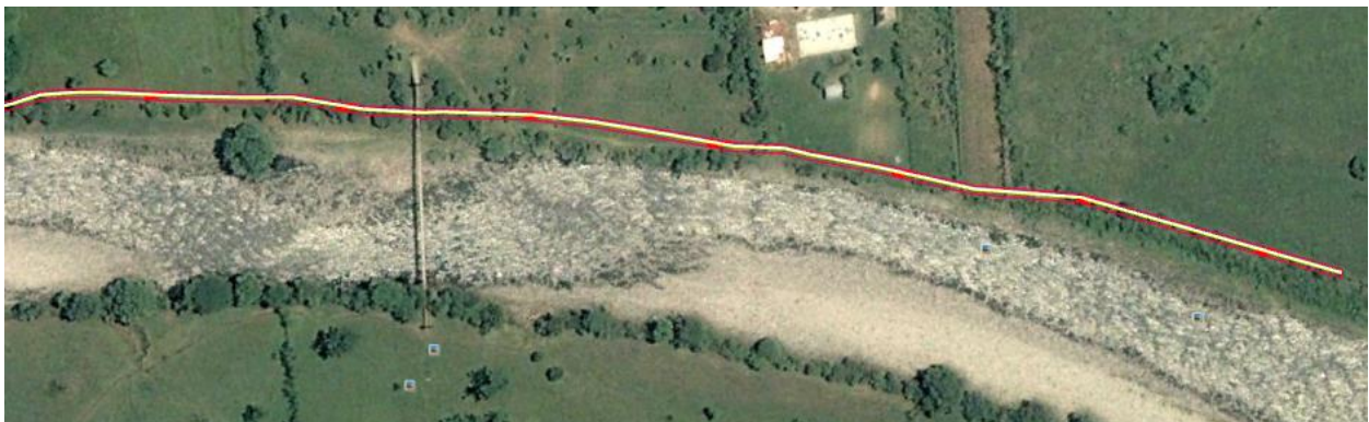
Imagen 23. Tramo donde serán removidos los cercos vivos sembrados con fines de delimitación
