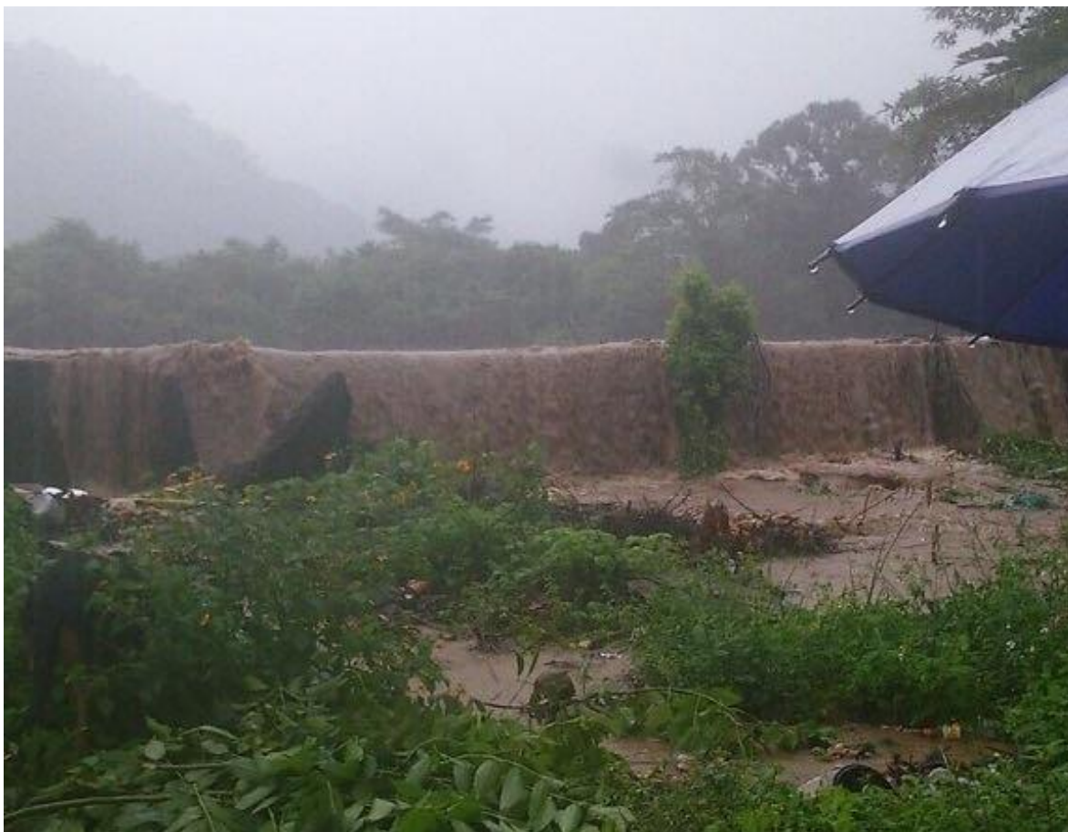
Imagen 3. Desbordamiento del río Usila durante la tormenta tropical “Ramón” en la zona que ya cuenta con un muro de encauzamiento
