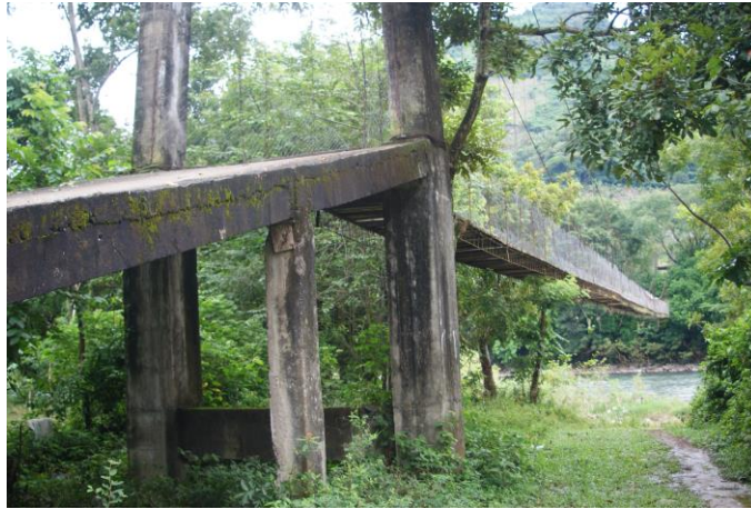
Imagen 7. Puente peatonal sobre el río Usila, el cual se encuentra sobre un tramo de la superficie del proyecto
