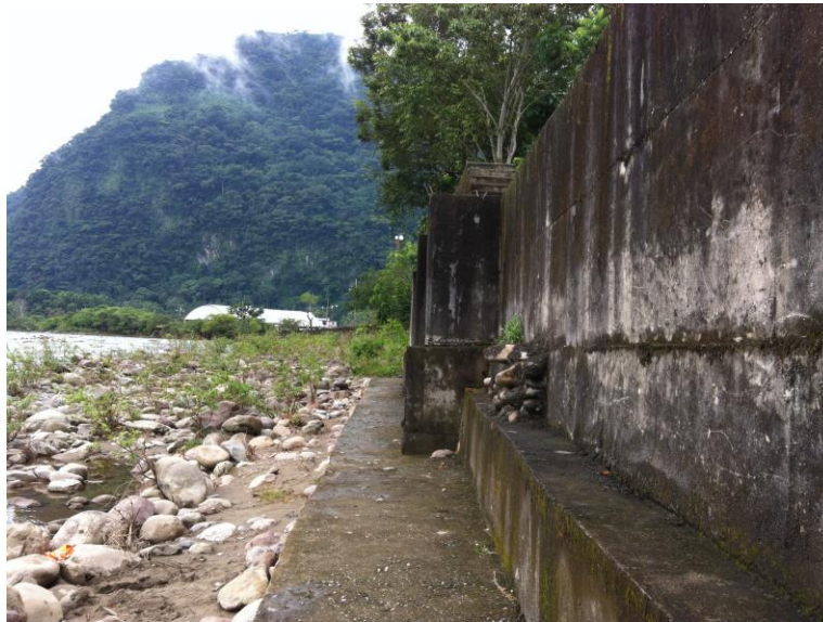
Imagen 9. Muro de encauzamiento existente hasta el km 1+080
