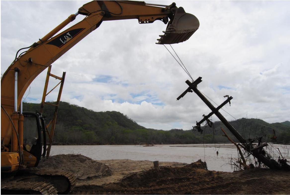
*Imagen 7. Afectaciones de predios en las márgenes del río Copalita, llegando a arrastrar inclusive las líneas eléctricas que estaban ubicadas a mas de 100 metros del nivel ordinario del río Copalita*
