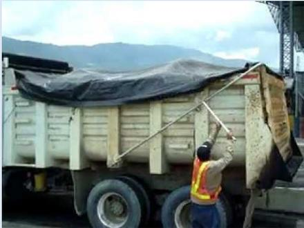
Ilustración 1 Colocación de lona (enlonado de camiones de transporte de material)
