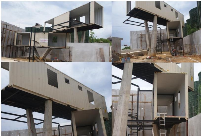
ILUSTRACIÓN II-8 CONTENEDORES 1 Y 2 EN PROCESO DE CONSTRUCCIÓN CON AVANCE DEL 80%
