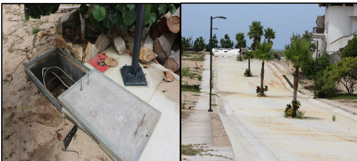
Construcción del registro subterráneo para el abastecimiento de la Luz Pública en el Residencial El Origen
