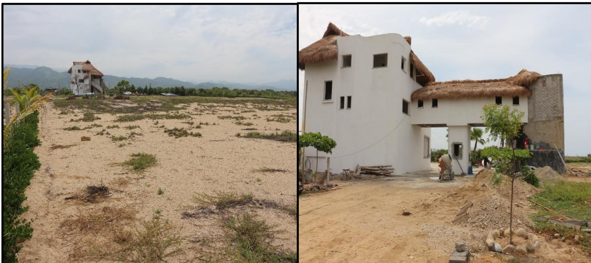
Casa muestra o casa tipo la cual deberá ser considerada para la construcción de las 35 casas restantes en el Residencial El Origen
