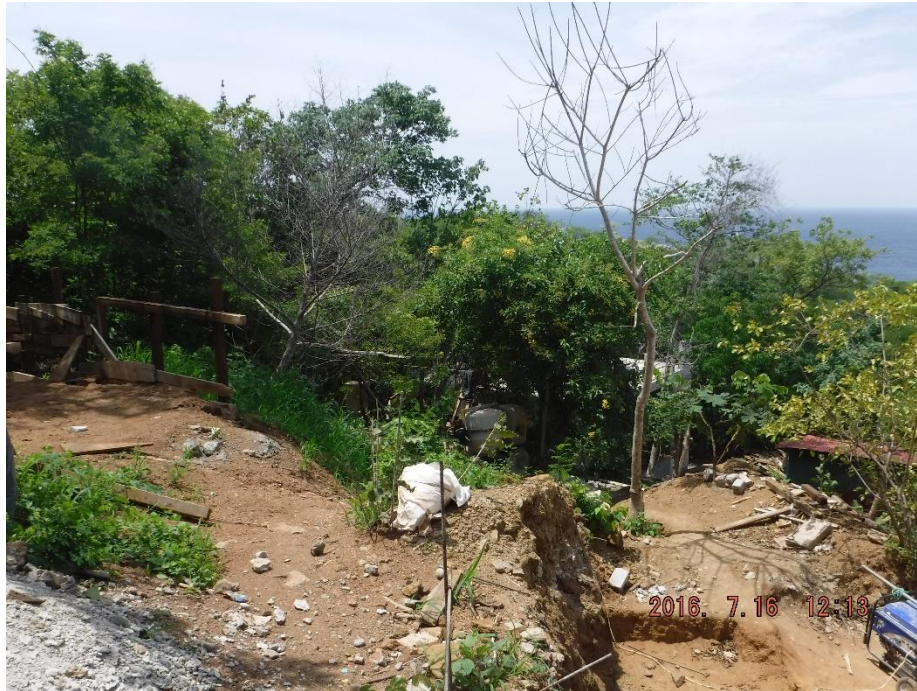
Figura VIII.3 Vista panorámica de la zona.
