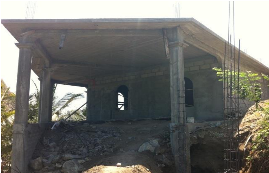
Figura 2.4 Fotografías del muro de tabique y concreto armado y corredor.
