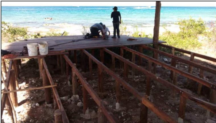
La imagen muestra la colocación del deck de madera, sobre los pilotes y los largueros.
