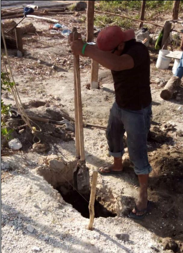
La excavación se realizará por medios manuales (pico y pala). Para la construcción de las zapatas se realizarán excavaciones de 70 cm de profundidad como máximo, dependiendo de la profundidad que se encuentre la piedra laja.
