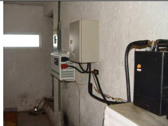
Convertidor de energía que la canaliza a las baterías.
