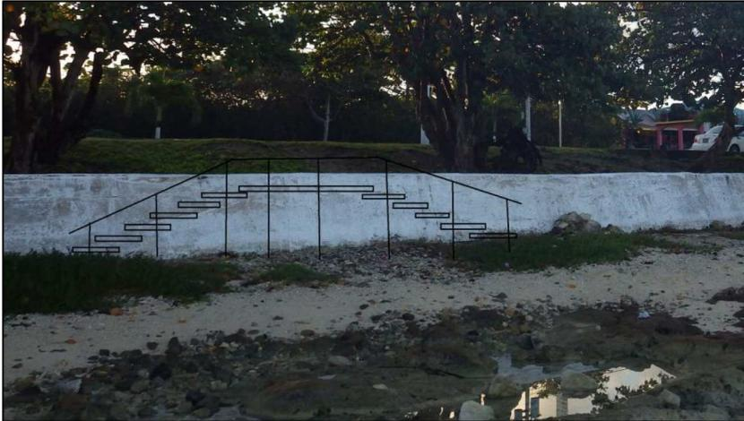
La presente imagen muestra el muro de contención existente, el cual servirá para “anclar” la escalera de acceso a la playa; es decir se aprovechara el muro, realizando perforaciones en él, para que el esqueleto de la escalera se fije y así darle resistencia a la escalera.
