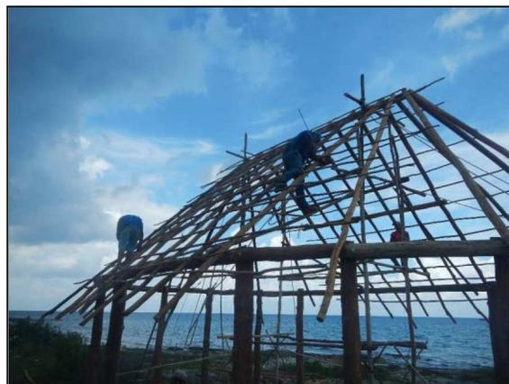
La imagen es un ejemplo constructivo de la estructura del techo, el cual será a base de madera unida con tornillos galvanizados.
