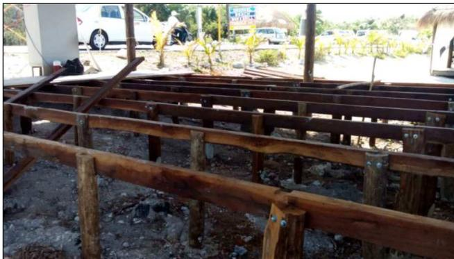
Una vez colocados los pilotes que le darán estabilidad al deck, se procederá a colocar los largueros, vigas y/o travesaños que le darán forma a la estructura (armazón) del deck.
