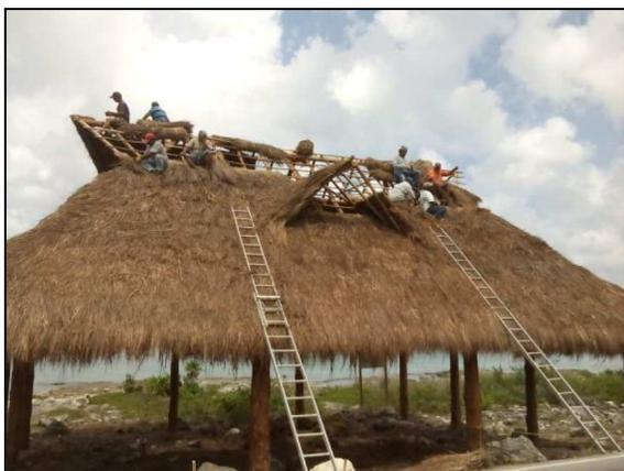
Una vez terminada la estructura del techo, se procederá a “tejer” el zacate comercial para forrar el techo de la palapa.
