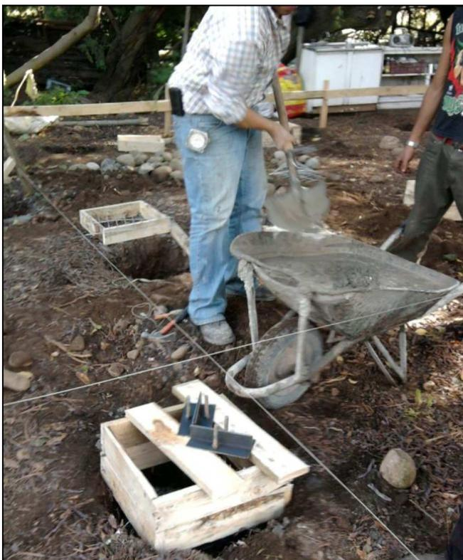
Posterior a las actividades de preparación del sitio, se realizara el trazo de desplante de las columnas y pilotes que le darán soporte a la estructura del deck de madera y al techo de la palapa.
