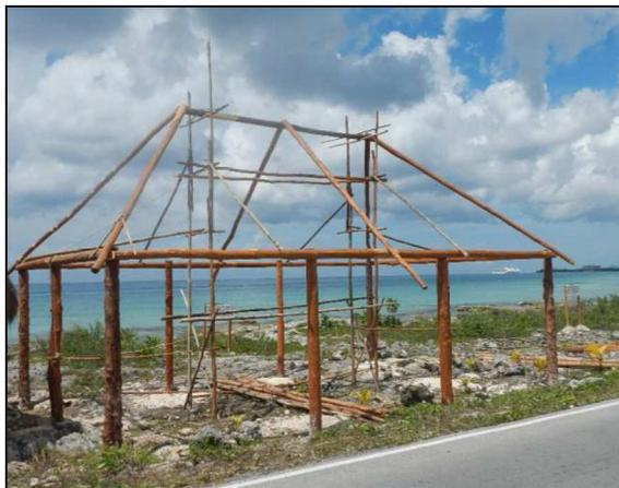
Después de colocar los postes de madera se procederá a construir sobre ellos la estructura del techo de la palapa bar, la cual será de madera.
