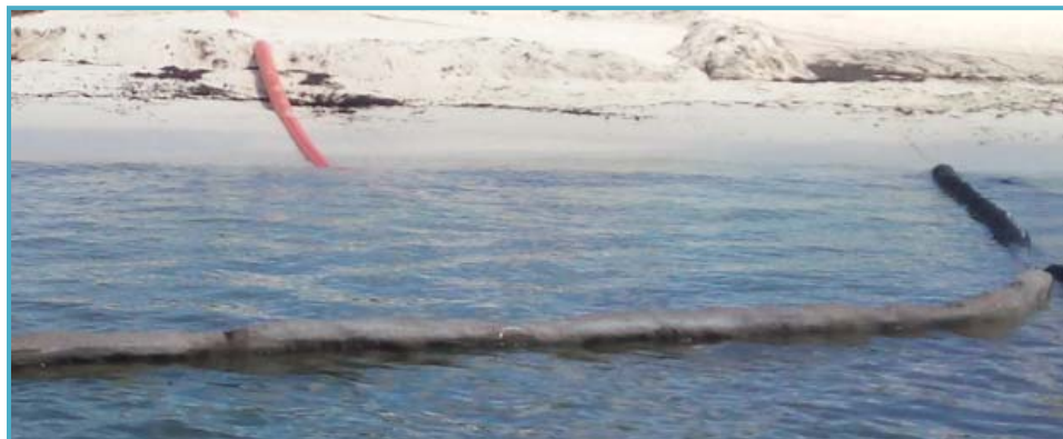
Figura II_ 26. Descarga de arena sobre la playa.
