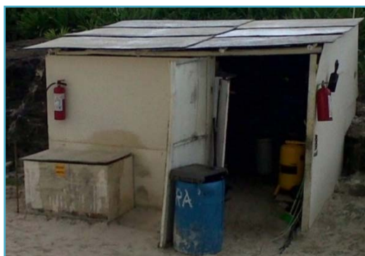
Figura II_ 16. Ejemplo de bodega provisional.
