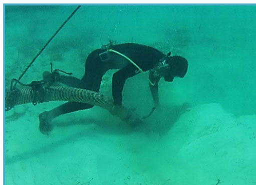
Figura II_ 27. Colocación de tuberías y mangueras para el transporte de arena.
