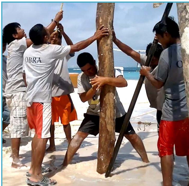
Figura II_ 31. Proceso de chifoneo y colocación de los pilotes de soporte.
