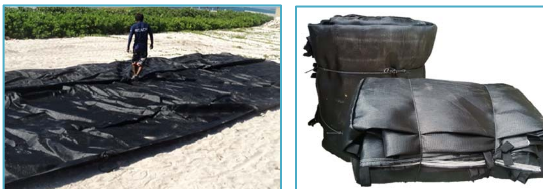
Figura II_ 20. Tubos de geotextil para el desplante de rompeolas.
