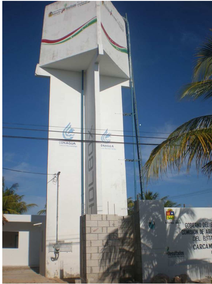
Fig. 24.- Cárcamo de agua potable CAPA Isla Holbox, Quintana Roo
