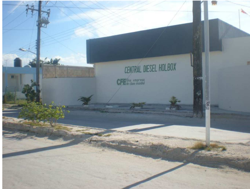
Fig. 25.- Planta generadora de energía eléctrica CFE Isla Holbox.
