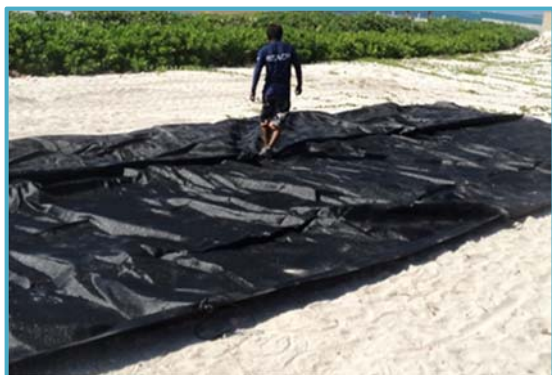
Figura II_18. Tubos de geotextil para el desplante de rompeolas.
