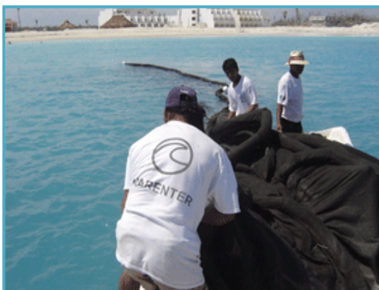
Figura II_ 23. Colocación y funcionamiento de malla antidispersión, en proyectos similares.
