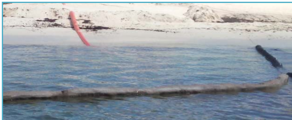
Figura II_25. Descarga de arena sobre la playa.
