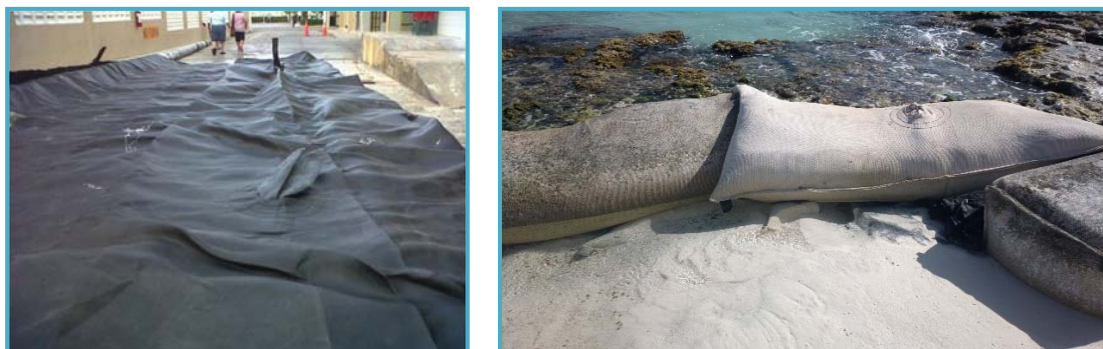
Figura II_ 14. Tubo de geotextil vacío y ejemplo de elemento de geotextil temporal de apoyo colocado sobre la playa.
