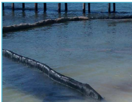
Figura II_ 23. Colocación y funcionamiento de malla antidispersión, en proyectos similares.
