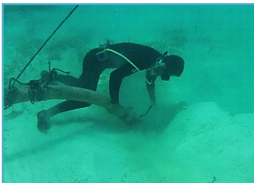
Figura II_26. Colocación de tuberías y mangueras para el transporte de arena.
