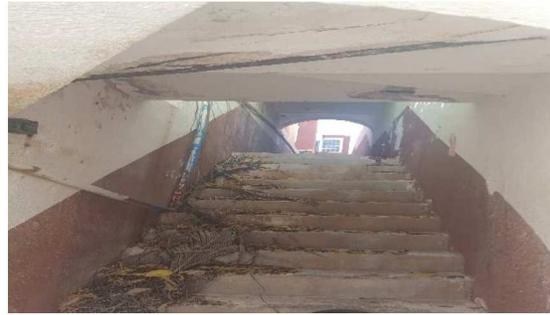
Fotos. Perspectivas de otras áreas del hotel, obsérvese las fracturas, residuos y daños estructurales ocasionados por la salinidad de la zona donde fue construido el hotel.
