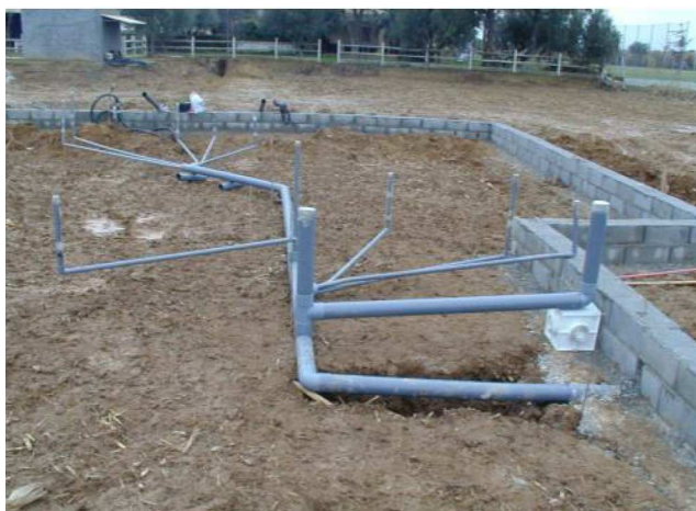
Cimentación con tubería y pasatubos
