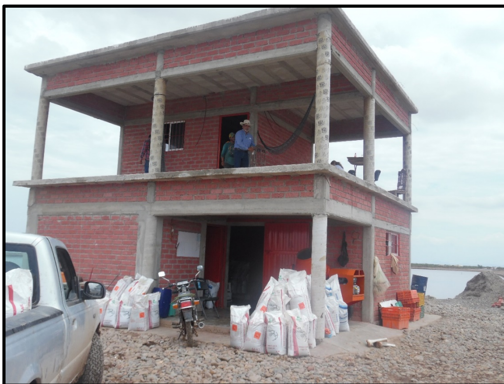
Figura II.7. Instalaciones (bodega/almacén) en la granja Sociedad Cooperativa Acuícola Aguila-socho, S. de R.L. de C.V. (Sección La Brecha)
