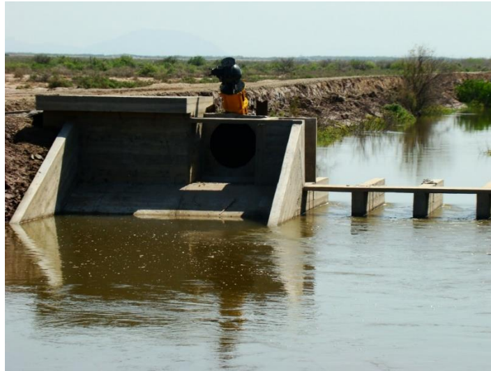
Figura 2.10 Cárcamo de re-bombeo en dren de descarga.
