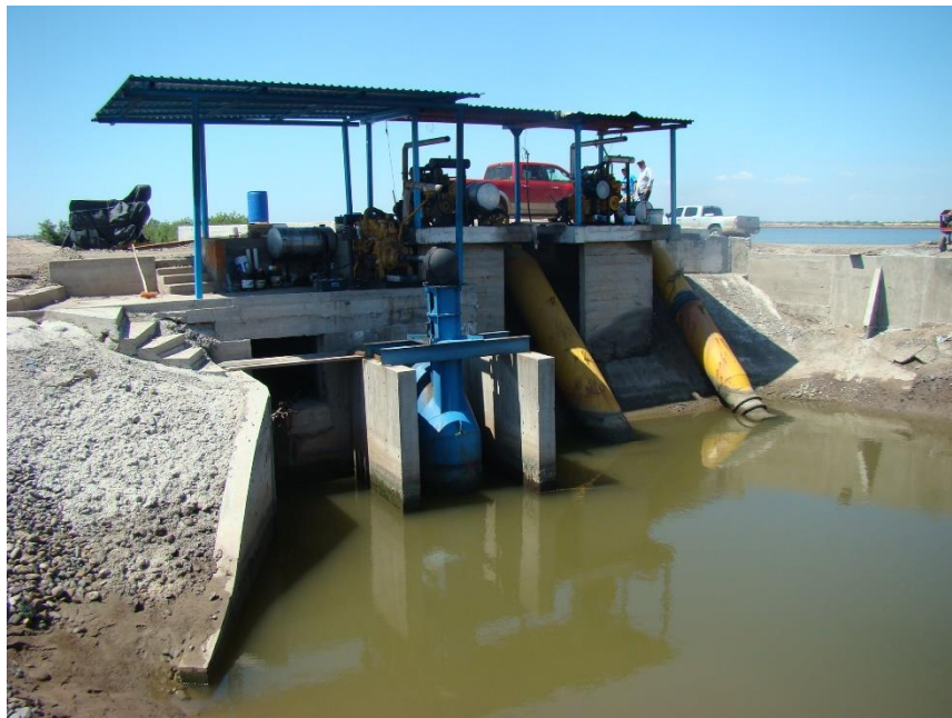
Escenario actual del cárcamo de bombeo
