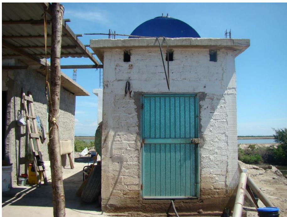
Figura 2.14 Baño dentro del mismo campamento.
