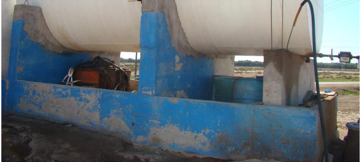
**Figura 6.10** Modelo análogo para el muro de contención del tanque diesel.
