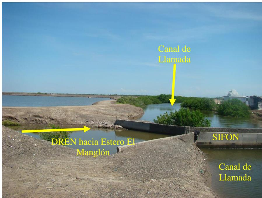
**Figura 2.6** Condición del dren de descarga y sifón
