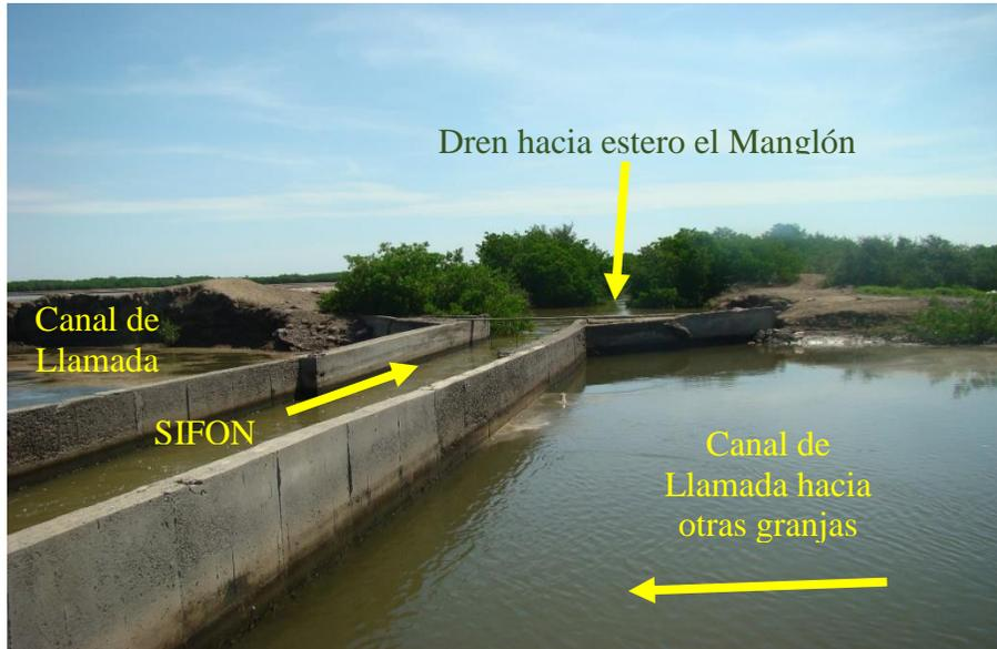
Figura 2.7 Condición del dren de descarga y sifón
