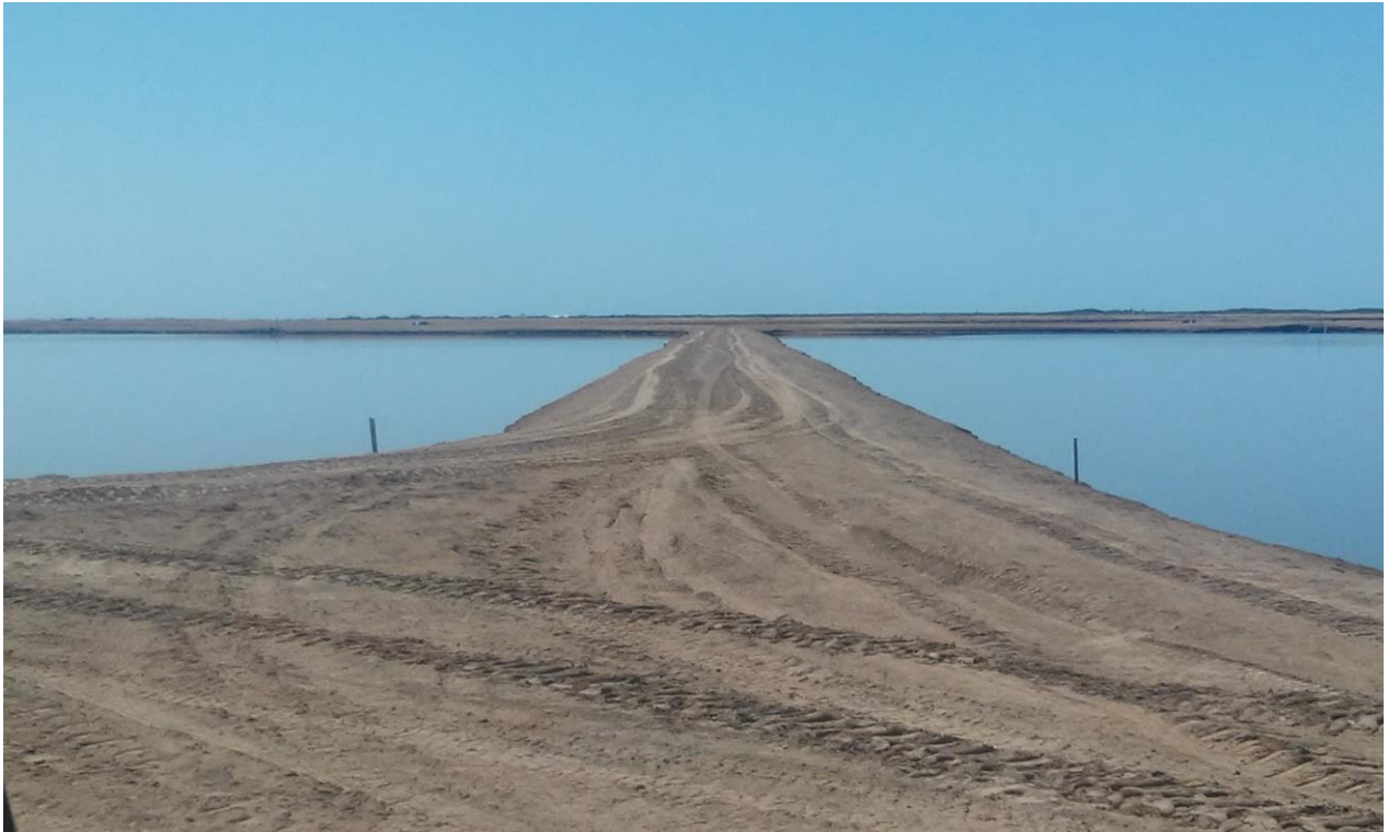
Figura 2.3 Escenario Actual de los estanques operantes
