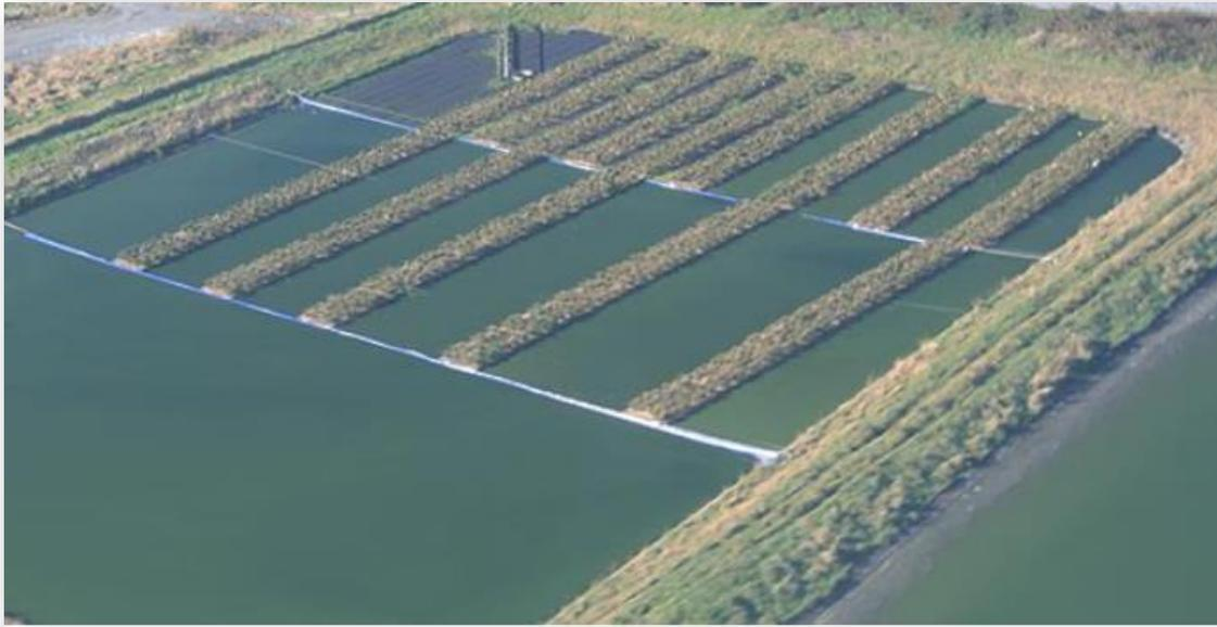
Figura 32. Muestra del sistemas de Chinampas para tratamiento de agua en cuerpos acuáticos de mediana y gran escala.
