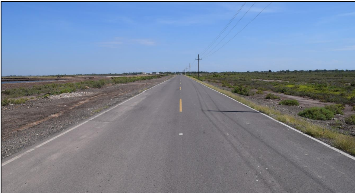
Granjas acuícolas y carretera Guasave- Las Glorias.
