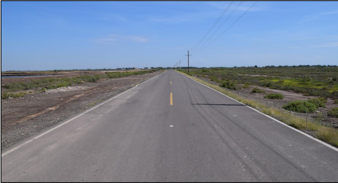
Granjas acuícolas y carretera Guasave- Las Glorias.
