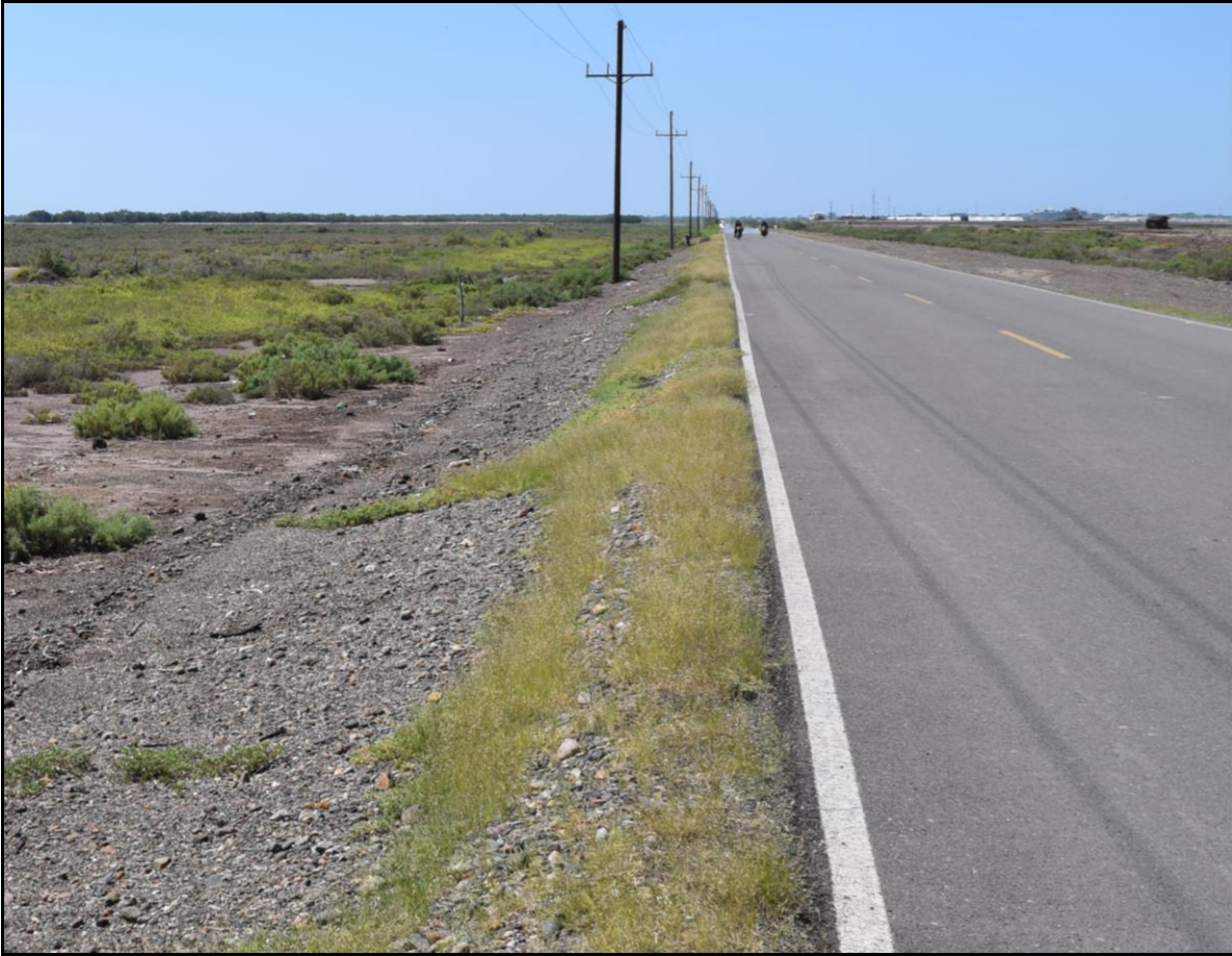
Carretera y derecho de vía de la carretera Las Glorias – Guasave, así como granjas acuícolas aledañas.
