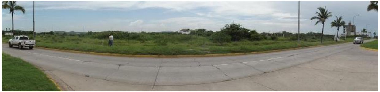
Vista frontal del predio hacia la costa, foto tomada del límite Oeste del predio.
