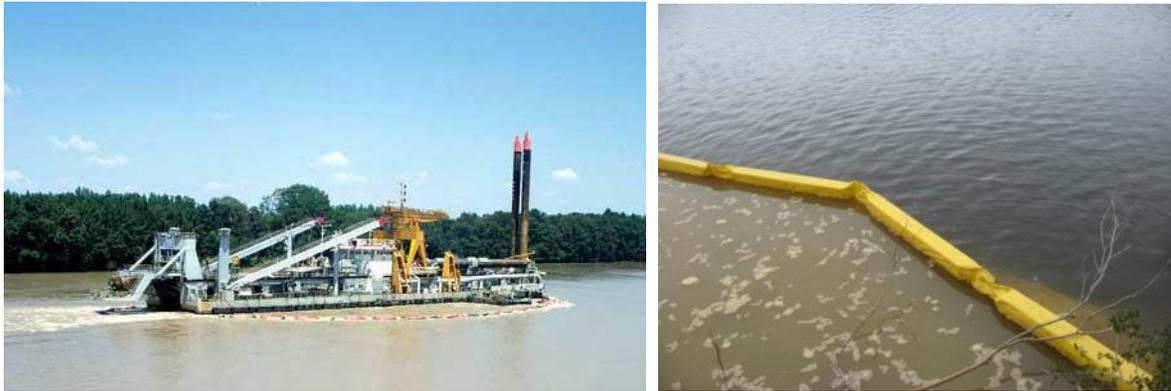
Figura 1. Dragado hidráulica de succión utilizando pantalla de sedimentos finos (silt courtain), nótese a la derecha la eficiencia en la contención
