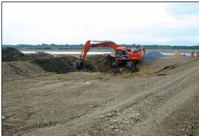
Imagen 1. Esta imagen ejemplifica la formación de bordos perimetrales usando el mismo material producto de la nivelación (despalme).
