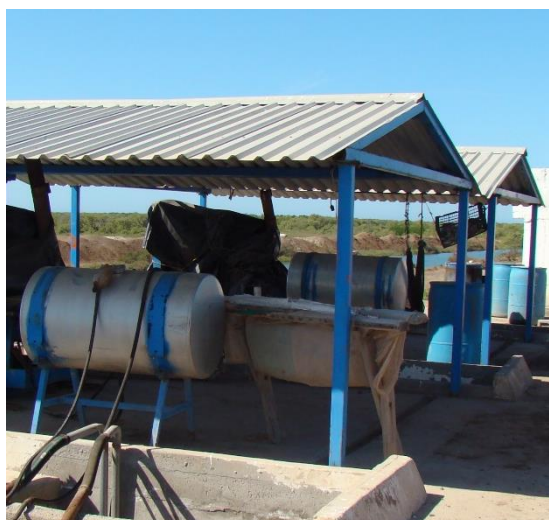
Figura 6.10 Modelo sardineles y techumbre para protección de carcamo de bombeo. análogo para
