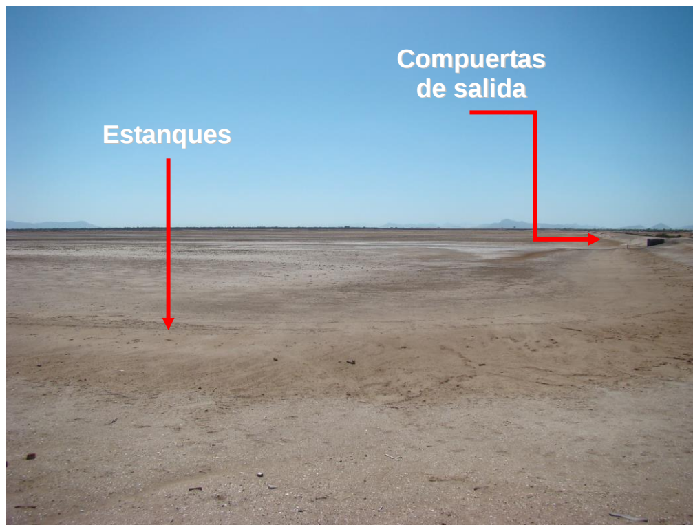
Escenario actual de los estanques existentes (sin operación)
