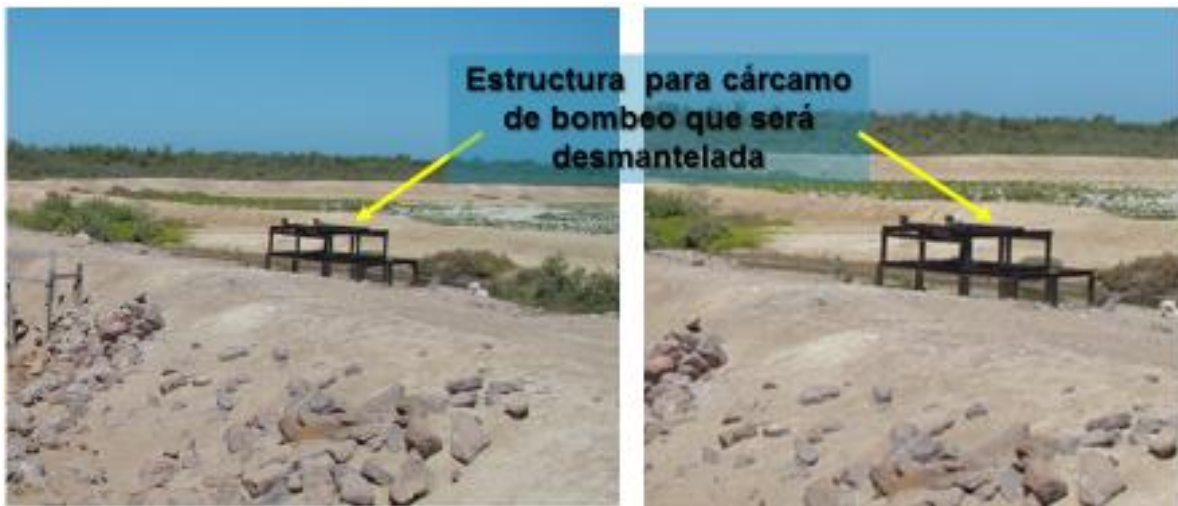
Figura 2.7 Escenario Actual estación de bombeo
