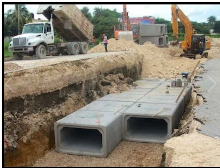
Figura II.12 Prototipo de entubamiento de reservorio
