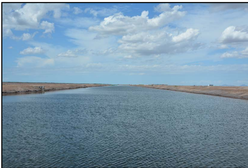
Figura IV. 14. En esta fotografía puede observarse las secciones del predio en operación y sin vegetación
