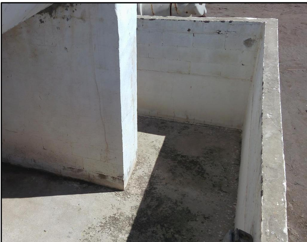
Fotografía 8. Contención en caso de derrames de Diésel.
