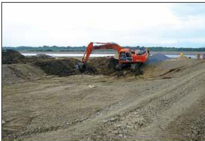
Imagen 1. Esta imagen ejemplifica la formación del bordo usando el mismo material producto de la nivelación (despalme).
