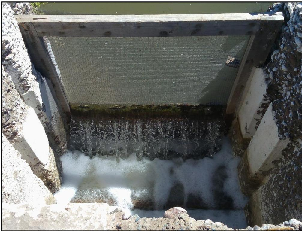
Fotografía 10. Malla filtradora a la entrada de los estanques para evitar la entrada de materiales que puedan afectar el cultivo del camarón.
