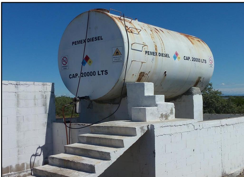
Fotografía 7. Tanque para almacenamiento de Diésel con capacidad de 20,000 Lts.
