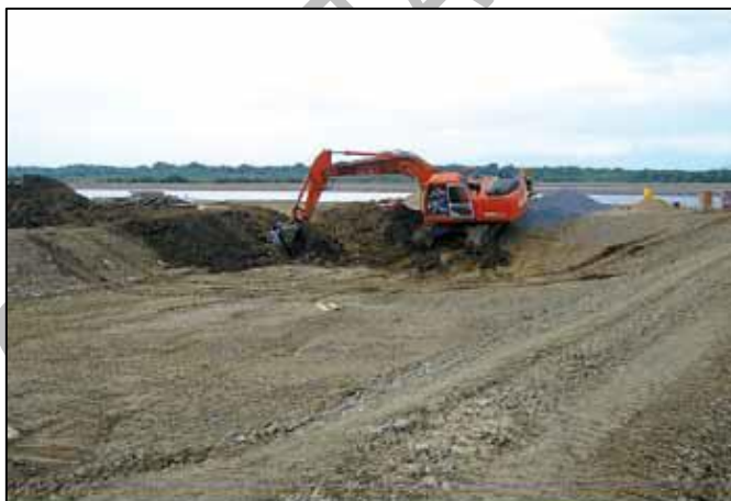
Imagen 17. Esta imagen ejemplifica la formación del bordo usando el mismo material producto de la nivelación (despalme).
