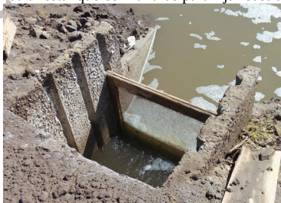
Fotografía No. 2.- Estructura de alimentación o llenado
