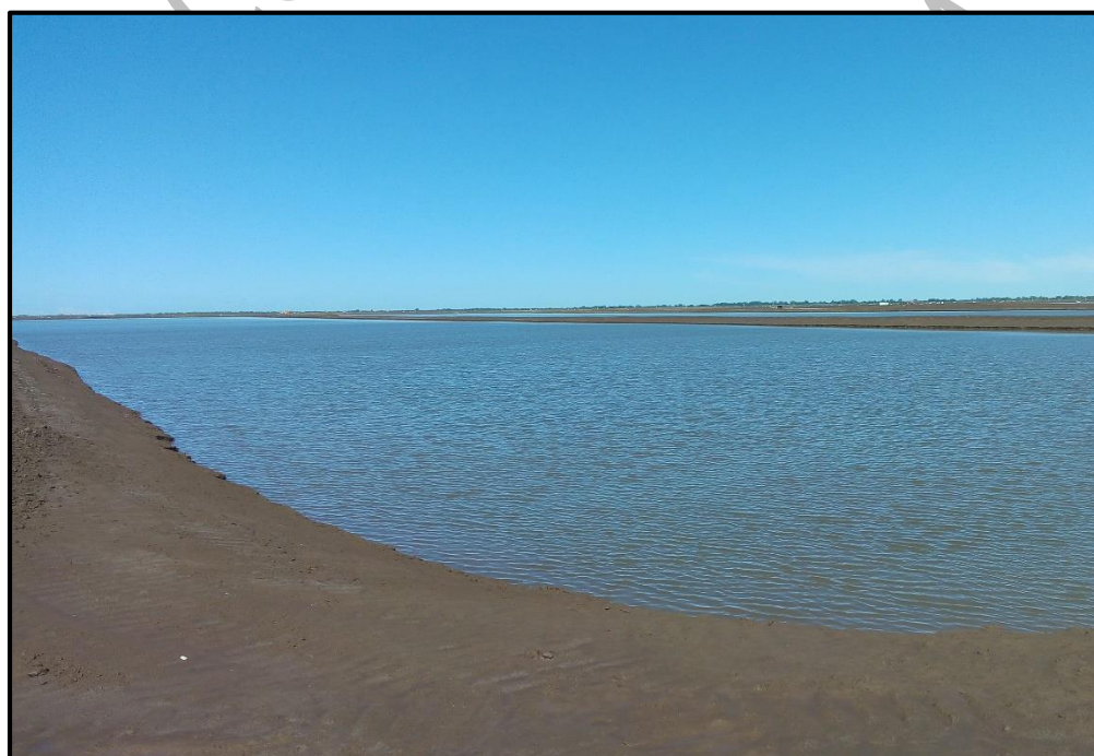
Fotografía No. 7. Vista general de del proyecto
