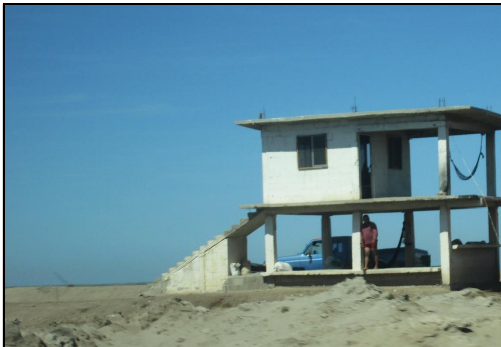
Fotografía No. 8. Caseta de vigilancia.
