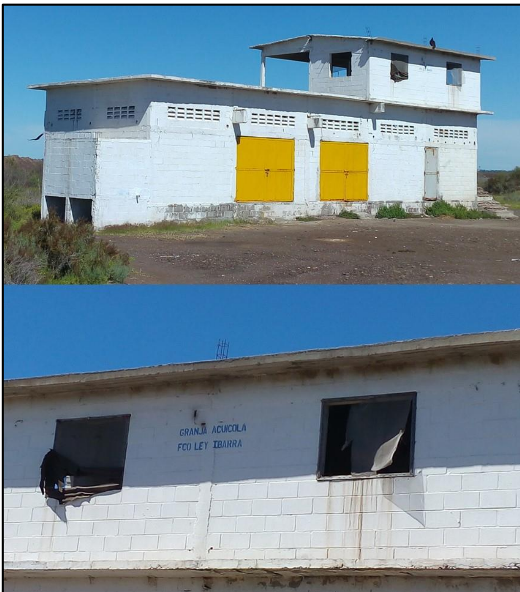
Fotografía 1. Infraestructura de la granja acuícola Francisco Ley Ibarra.
