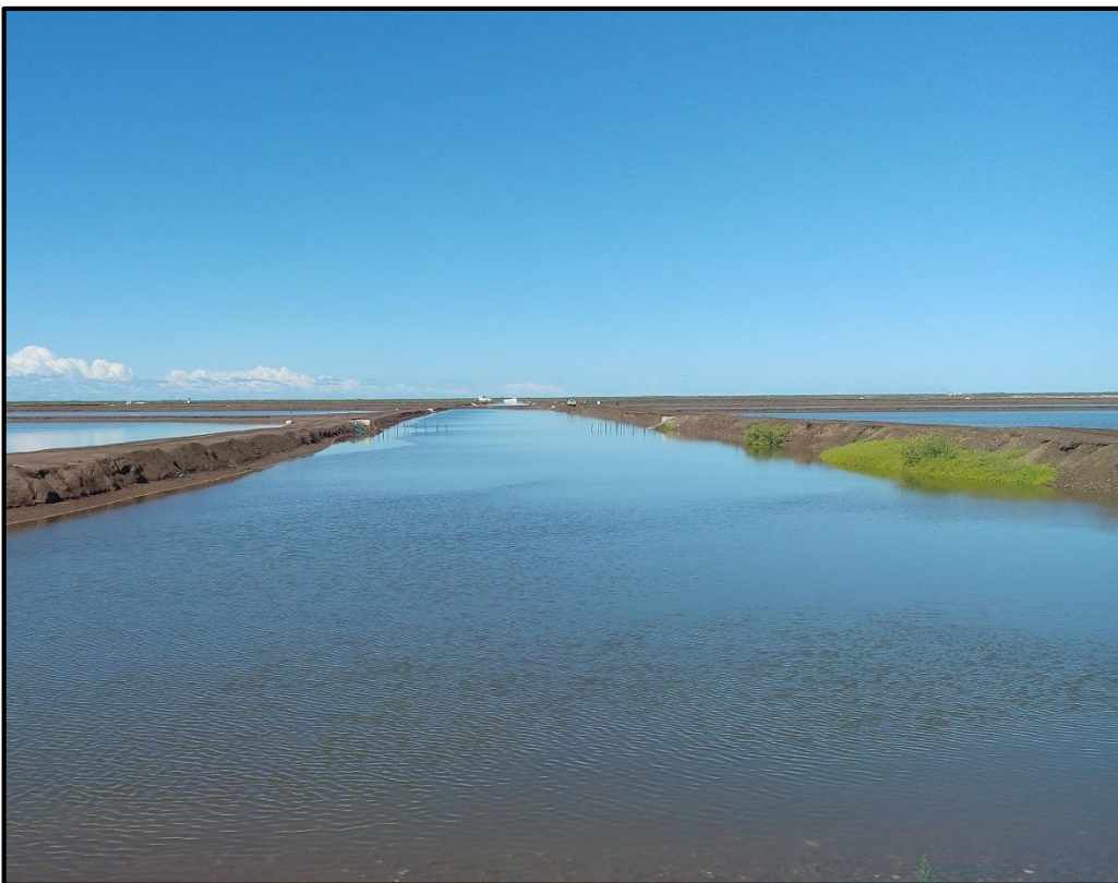
Fotografía 2. Canal reservorio de la granja acuícola Francisco Ley Ibarra.
