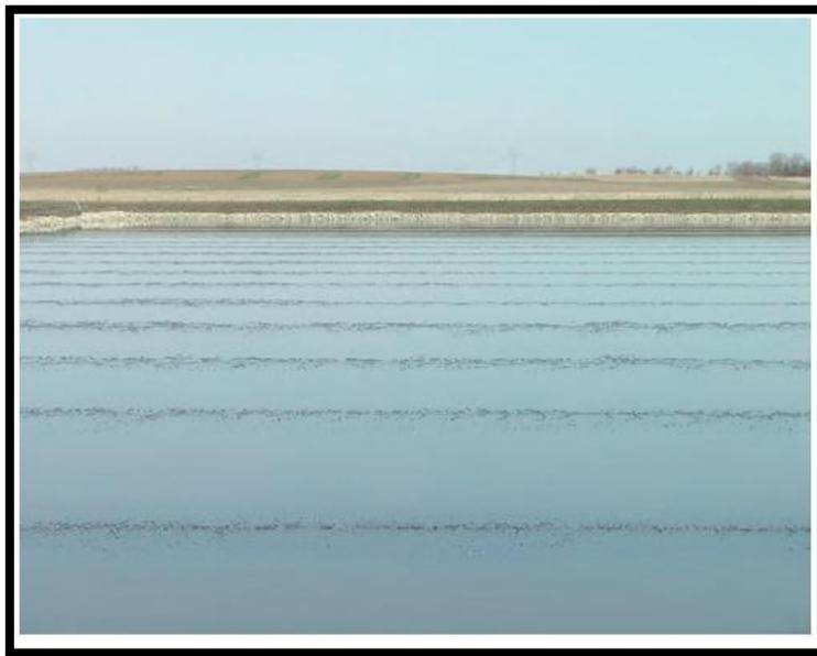
Figura VI.2. Disposición de aireación por del ADS en estructuras acuáticas para el tratamiento de efluentes
